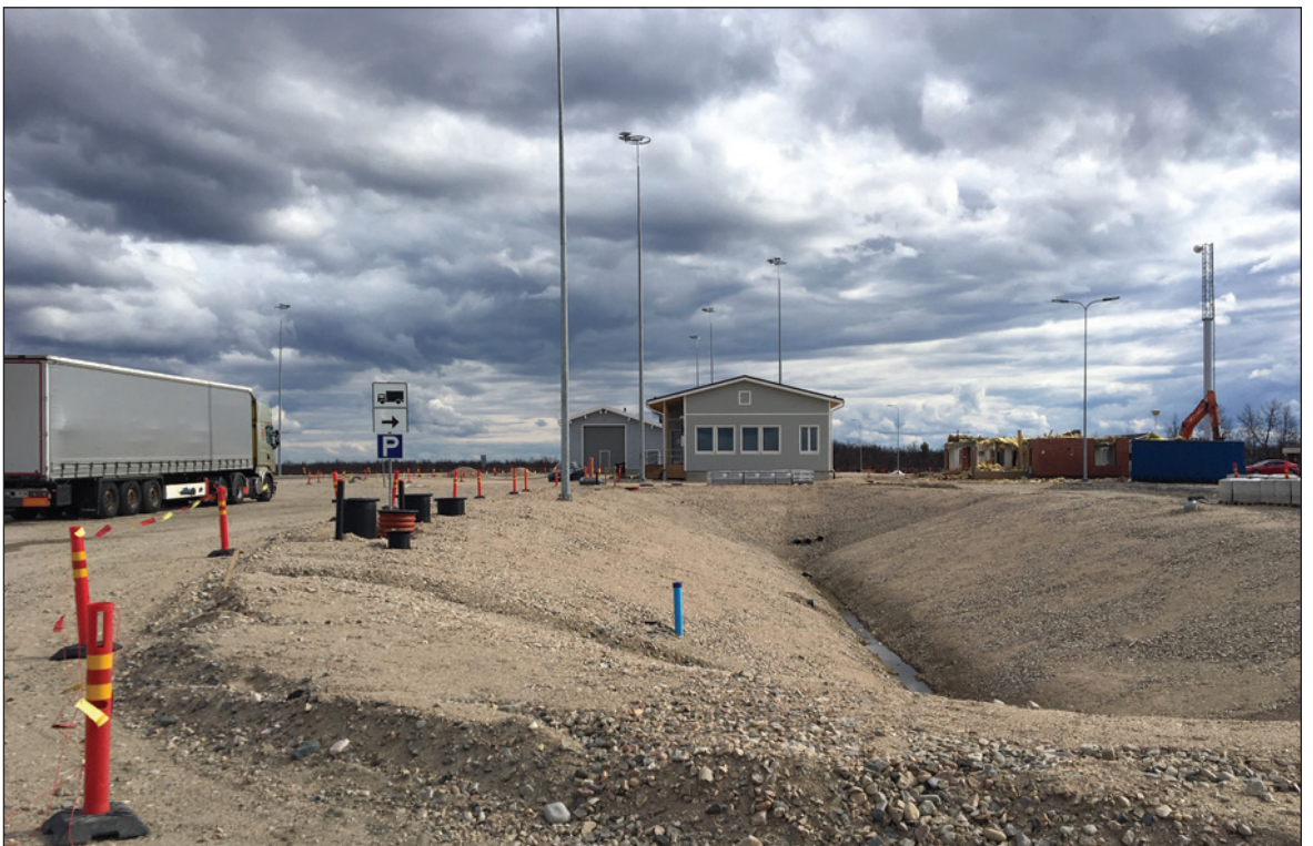
Rakennustyömaata kesällä 2019. Vanha tullirakennus on jo lähes purettu uuden rinnalta. Tommi Laukkanen.
