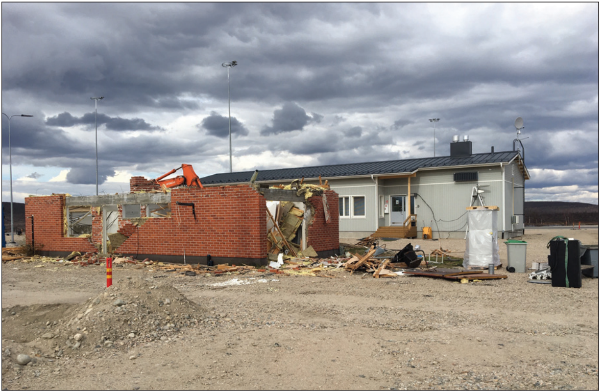
Vanhaa tullitaloa puretaan keväällä 2019. Taustalla uusi rakennus. Tommi Laukkanen.
