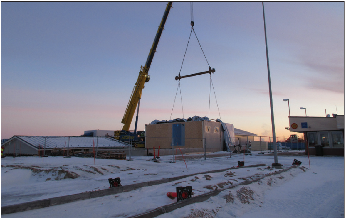
Elementtejä pystytetään työmaalla marraskuussa 2018. Heikki Lauhamaa
