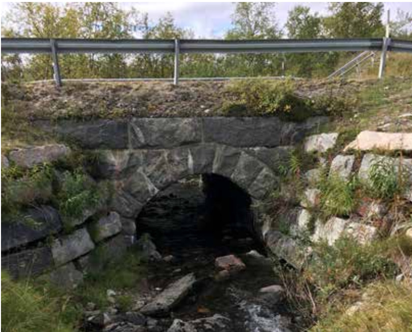
Ahdaskurun silta on Lapin ainoa kiviholvisilta, joka säästy sodan tuhoilta. Silta sijaitsee Tullin ja valtakunnanrajan välisellä maantieosuudella noin neljä kilometriä valtakunnanrajalta. Silta hyväksyttiin virallisesti museokohdeksi vuonna 1982. Kuva: Petri Kannasvuo
