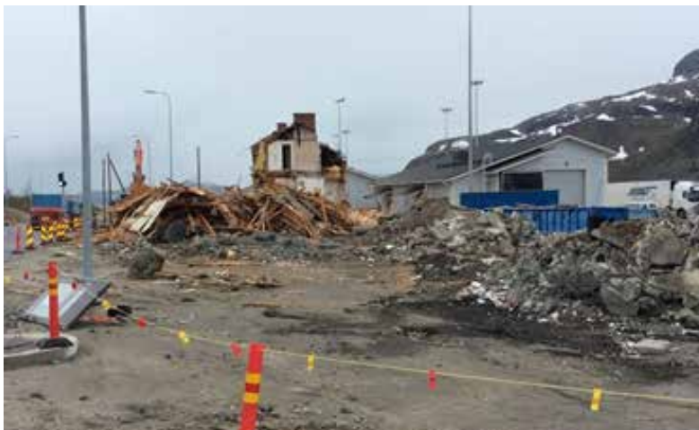
Entisten tullirakennusten purku kesäkuussa 2017. Kuva: Kilpisjärven tulli
