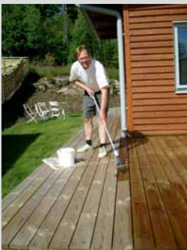
TERASSIN 2. TYÖVAIHE SUOJAUS
