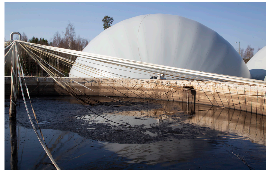
Lannan käsittely biokaasulaitoksessa vähentää lannan metaanipäästöjä, parantaa hygieenistä laatua ja tuottaa samalla biokaasua, jota hyödynnetään yleensä lämmön tai sähkön raaka-aineena. KUVA: MAGNUS ÖSTMAN
