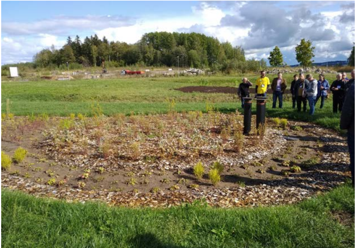
Hulevesien suodatuspilottikoe biohiilen avulla Tampereen Hiedanrannassa. Kuva: Anu Riikonen.
