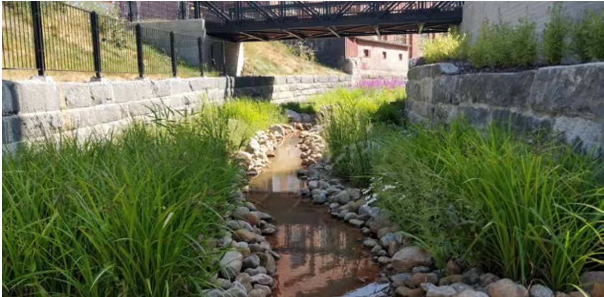
Kankaan kanavan valmis viherrakenne 10/2018. Ramboll
