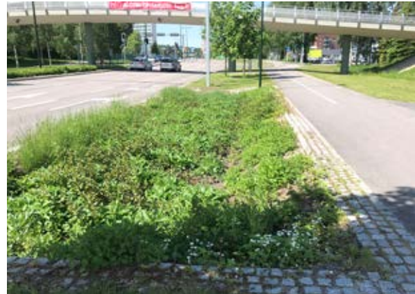
Tässä altaassa on tavallinen kasvualusta 400 mm ja alla hiekkasuodatin. Perennakasvillisuus voi selvästi paremmin kuin biohiili/sepelikasvualustassa, jossa kasvit ovat kärsineet kuivuudesta. Kuva otettu 11.6.2022, Ramboll.
