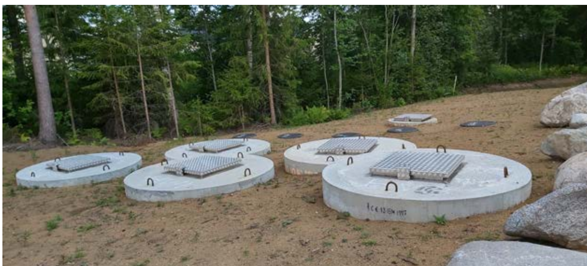
Suodatinkaivoilla 5 kpl tutkittiin eri suodatusmateriaalien toimivuutta. Kaivoissa on 40-50 cm kerros suodatinmateriaalia.
