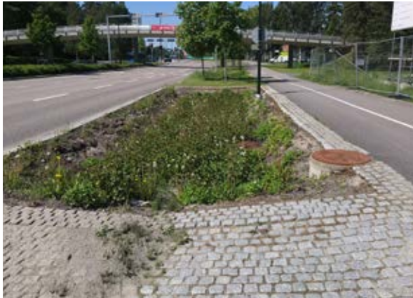
Merituulentien hulevesipainanteet, joiden kasvillisuutena ovat perennat. Biohiiltä on etualan painanteessa. Hulevedet laskeutetaan ensin kiveykselle. Kuva otettu 11.6.2022, Ramboll.
