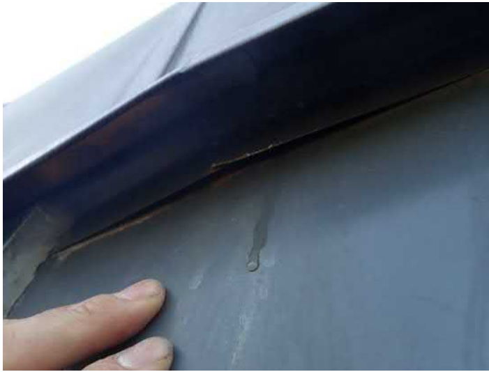
Kuva 12. Vettä peltien takaa
