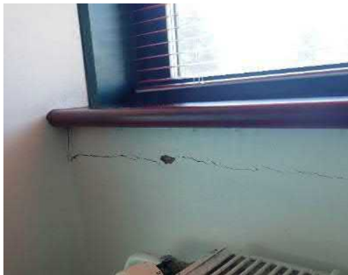
Kuva 54. Halkeama ulkoseinällä
