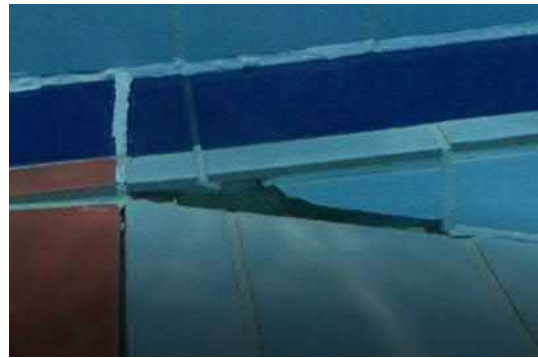
Kuva 38. Haljenneet laatat altaan sivulla
