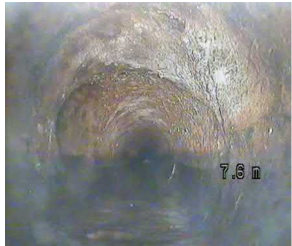
(kuva 8. kellarin huoltokäytävällä valurautainen runkoviemäri sisäpuolelta kuvattuna)
