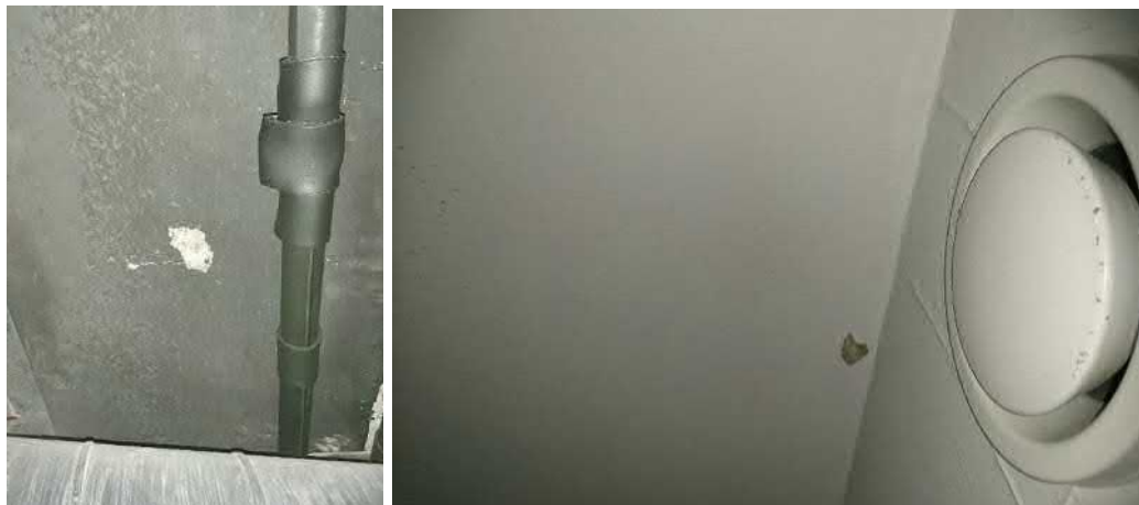
Näyte 12. Rapatun alakaton tasoite/maali. (valkoinen maali, harmaat paksut kerrokset) Ei sisällä asbestia.
