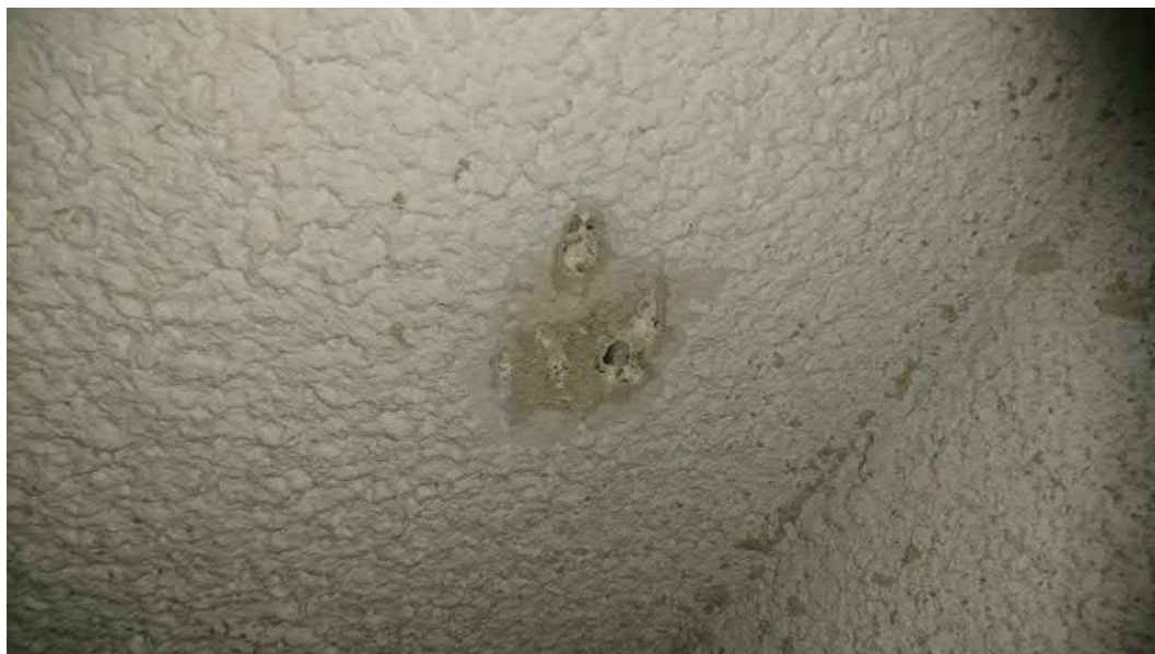
Näyte 12. Rapatun alakaton tasoite/maali. (valkoinen maali, harmaat paksut kerrokset) Ei sisällä asbestia.
