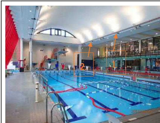
Kuva 63. Palkin rakenneavaus pisteet, nuolet oranssilla.
