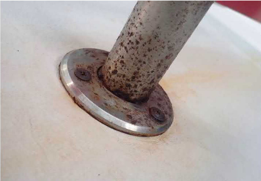
Kuva 13. Kaiteiden kiinnittyminen seinään
