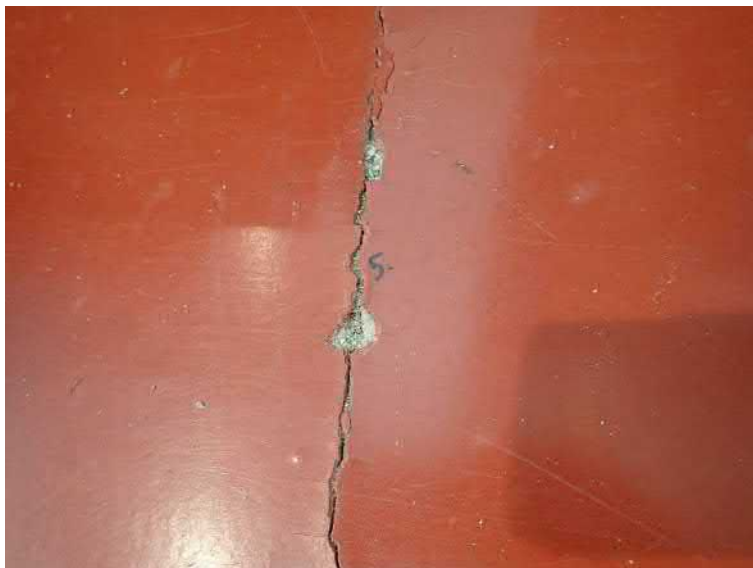
Näyte 5. Punainen pinnoite, liima ja tasoite. Ei sisällä asbestia.
