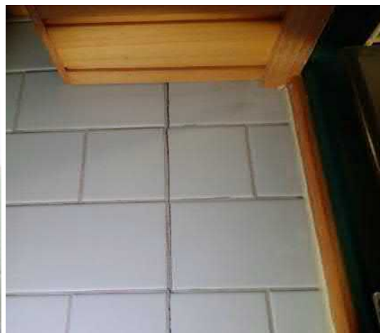
Kuva 23. Halkeama seinässä
