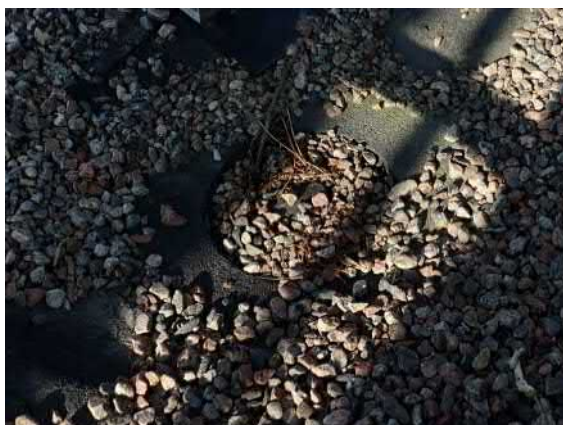
Kuva 17. Kattokaivo tukkeentumassa
