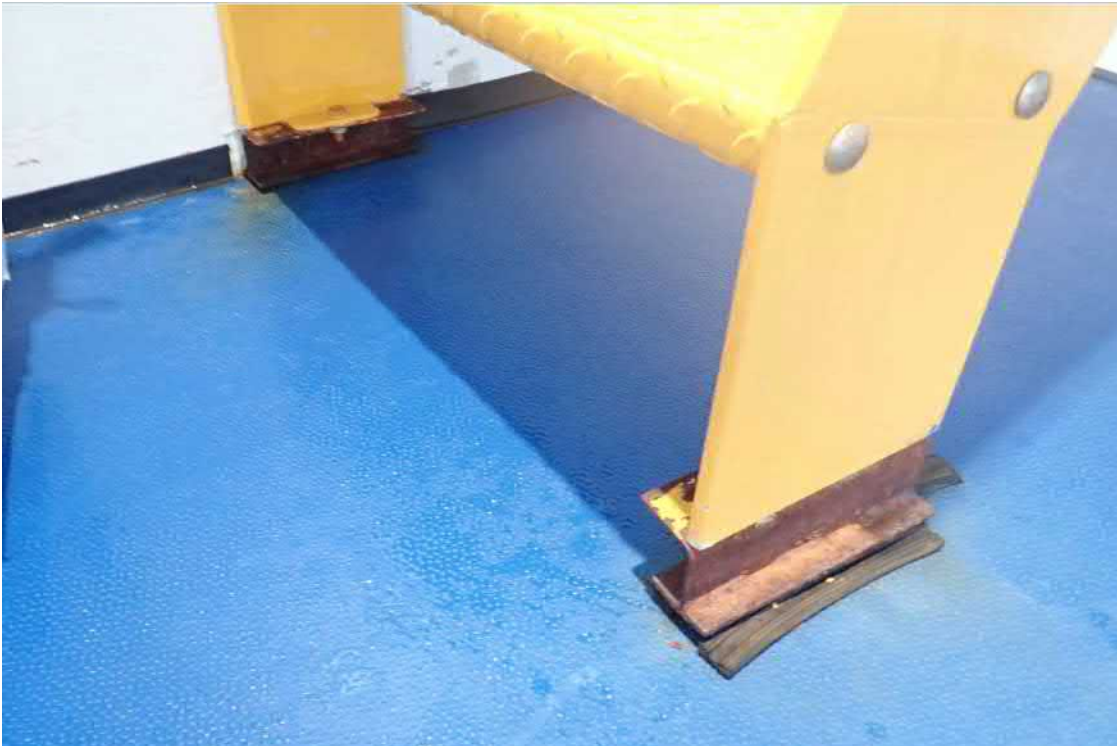
Kuva 10. Portaikon alapään kiinnitys hyppytornin tasolta toiselle.
