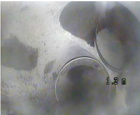
(kuva 9. kellarin huoltokäytävällä muovinen runkosadevesiviemäri sisäpuolelta kuvattuna)
