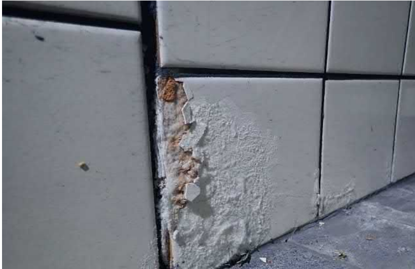
Näyte 3. Seinälaatta, sauma ja laastit. Ei sisällä asbestia.
