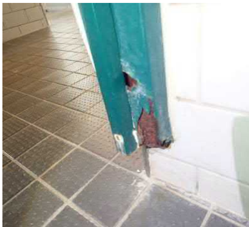
Kuva 22. Saunan oven karmi
