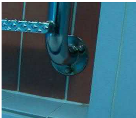
Kuva 41. Allastikkaiden kiinnikkeet
