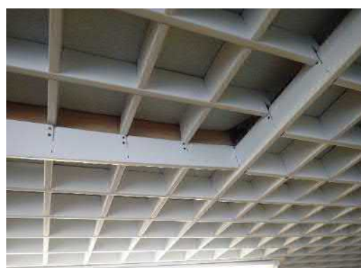
Kuva 25. Kattolevy epätiivästä
