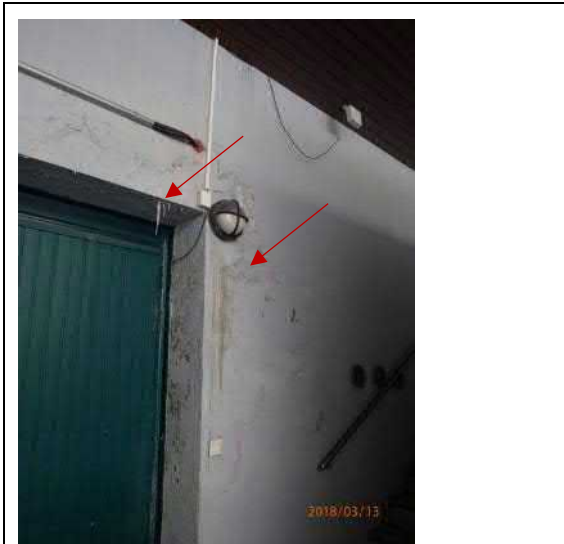
Kuva 58. Jääpuikko huolto-oven reunassa
