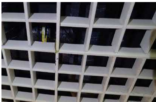
Kuva 27. Ritiläkatto kannateltu sähköjohdoilla
