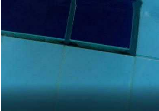
Kuva 37. Puuttuvat tiivisteet
