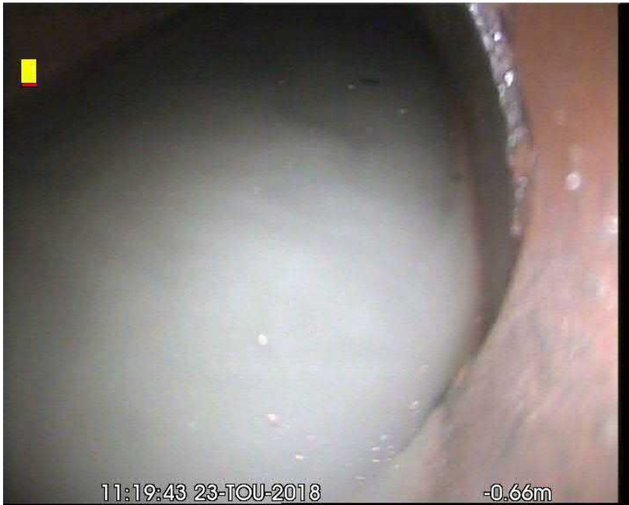
Kuva 8. Padotusta linjassa SOTV9.
