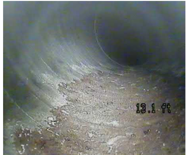
(kuva 14. kellarin huoltokäytävällä allasosaston poistokanava sisäpuolelta kuvattuna)
