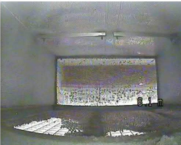
(kuva 15. allas osaston poistoilmakanava katossa sisäpuolelta kuvattuna)
