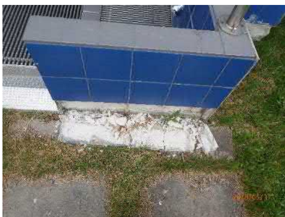
Kuva 50. Irronneita laattoja
