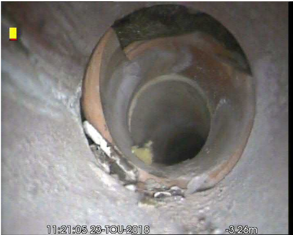
Kuva 9. Putkesta puuttuu osa linjassa SOTV9.
