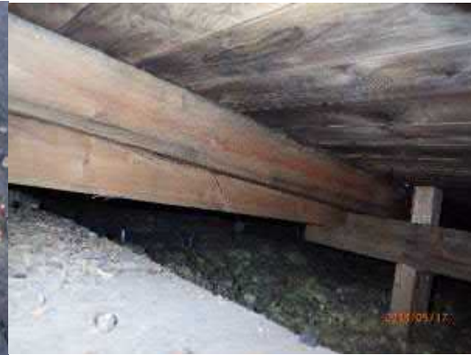
Kuva 13. Mustuneita rakenteita
