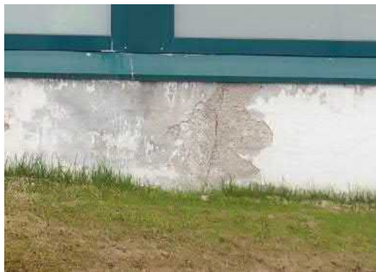
Kuva 9. Halkeilua sokkelissa
