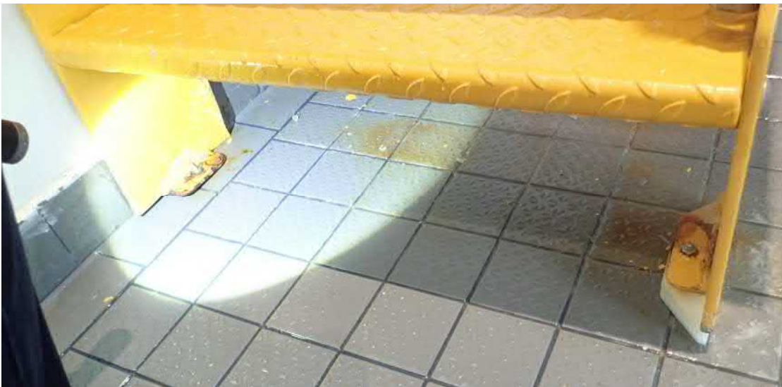
Kuva 9. Portaikon alapään kiinnitys
