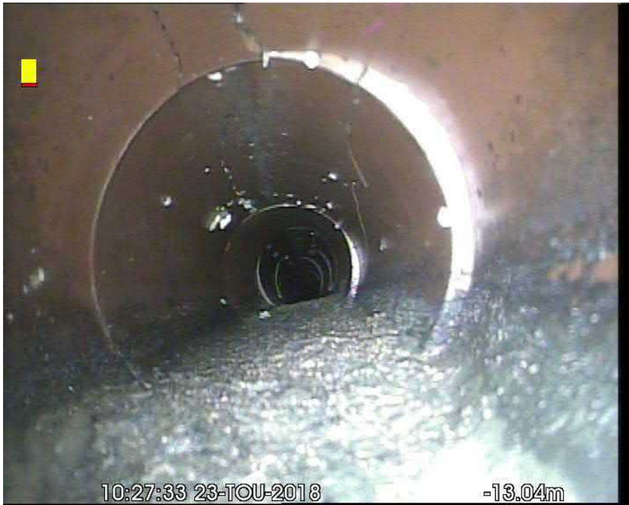
Kuva 6. Halkeamia linjassa SOTV6.
