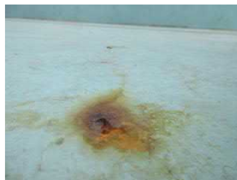
Kuva 47. Korroosiovaurioita
