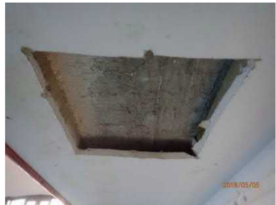
Kuva 64. Palkin alapintaa pisteestä 1. Ruiskurappaus asbestipitoinen.
