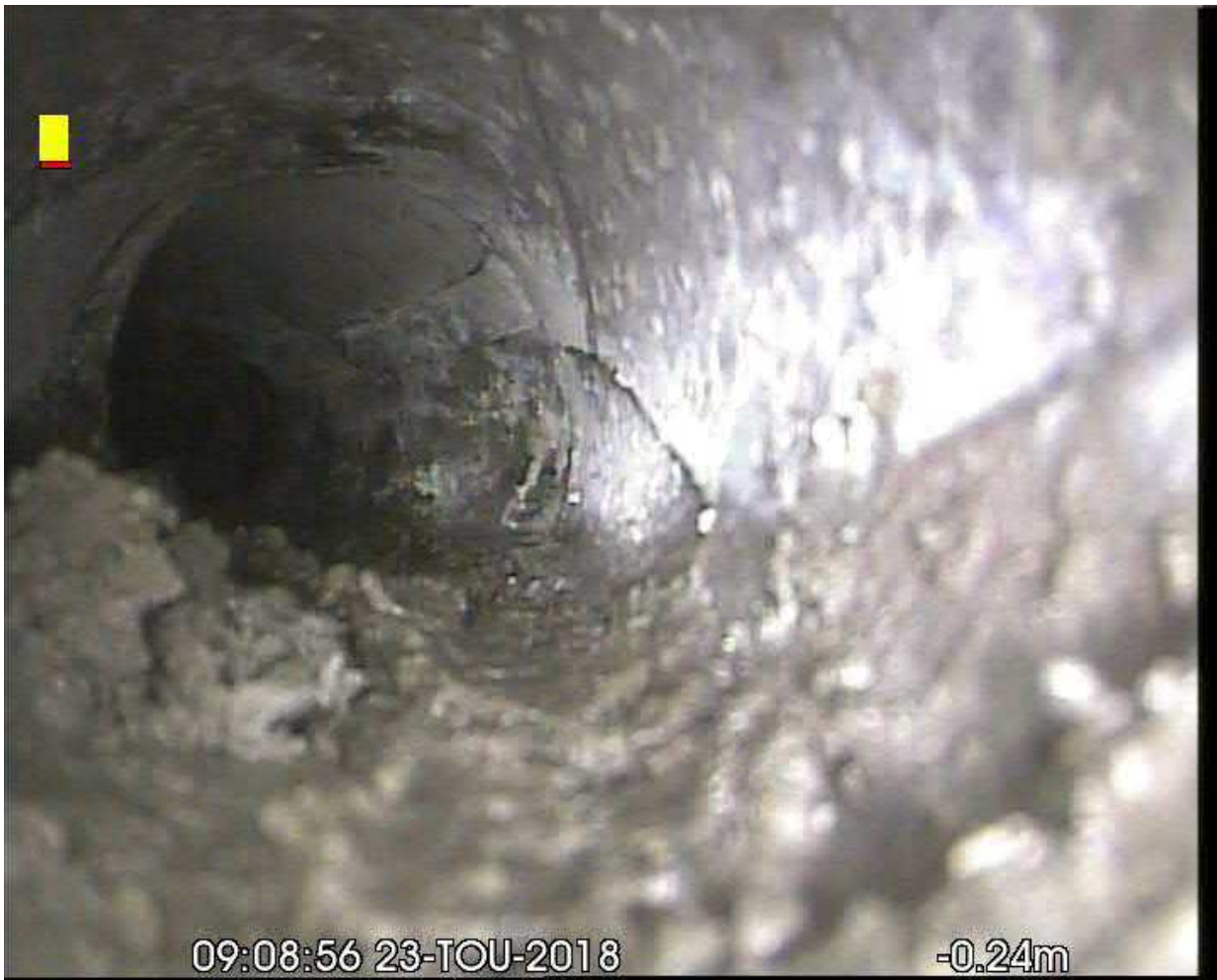
Kuva 3. Halkeama linjassa SOTV2.
