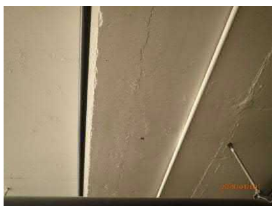
Kuva 76. Hyppytornin päädyn vahvistettu laatta.
