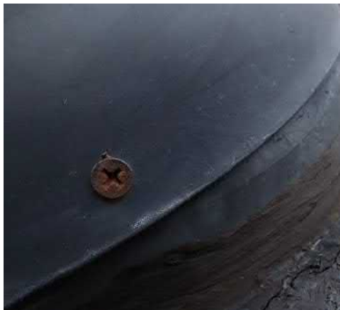
Kuva 18. Tuuletusputken kiinnitys
