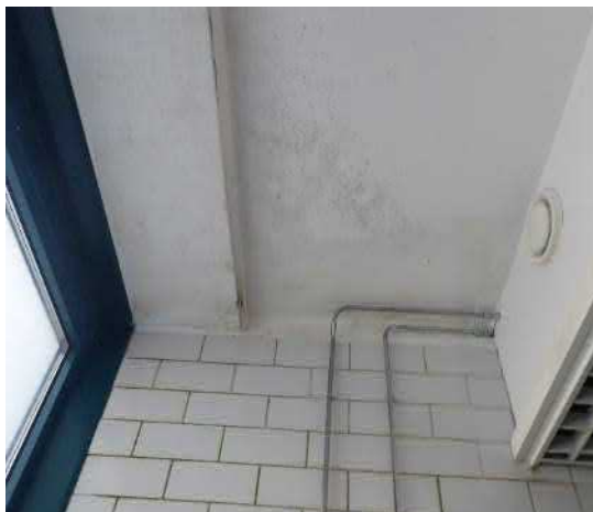
Kuva 20. Suihkunurkkaus mikrobikasvustoa Kuva 21. Ruostevaurioita kaiteiden kiinnikkeissä.
