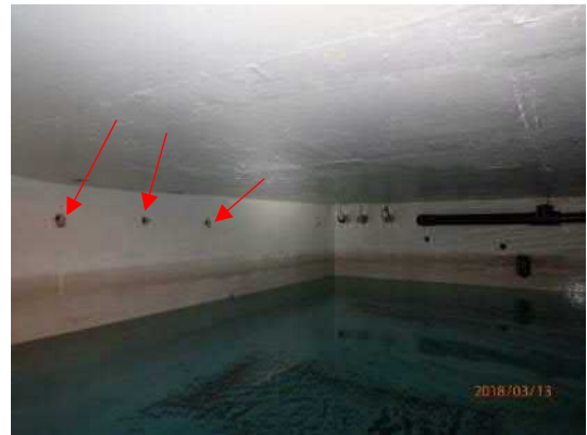
Kuva 79. Muottivälikkeiden paikkavalut irronneet tasausaltaissa.
