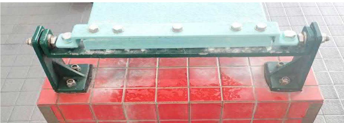
Kuvat 14,15 ja 16. Ponnahduslaudan kiinnikkeet
