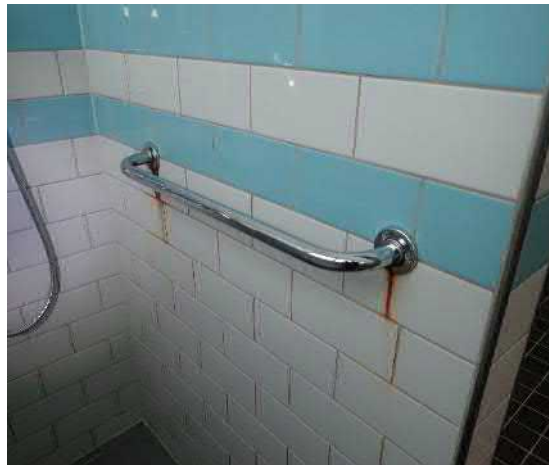
Kuva 20. Suihkunurkkaus mikrobikasvustoa Kuva 21. Ruostevaurioita kaiteiden kiinnikkeissä.
